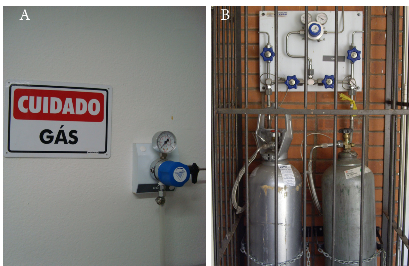
Figura 3. A) Adaptadores para gás \text{O}_2 e \text{CO}_2 ; B) Cilindros localizados na área externa do Biotério
