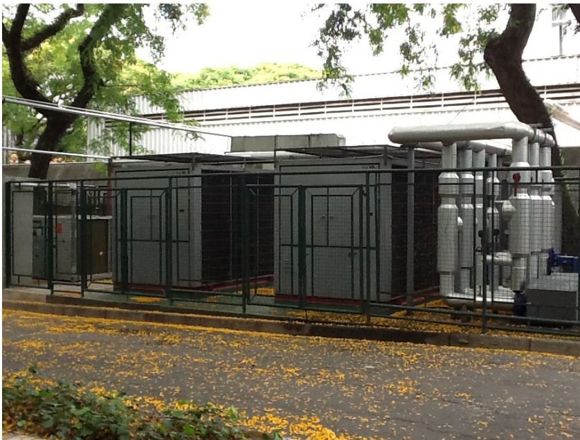
Figura 7. Chillers que atendem as seções de produção, experimentação e higiene e esterilização
